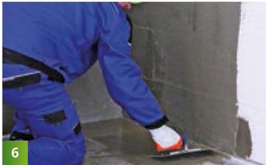
Po zaschnutí prvej vrstvy hydroizolácie natiahneme celoplošne druhú vrstvu hydroizolácie.
