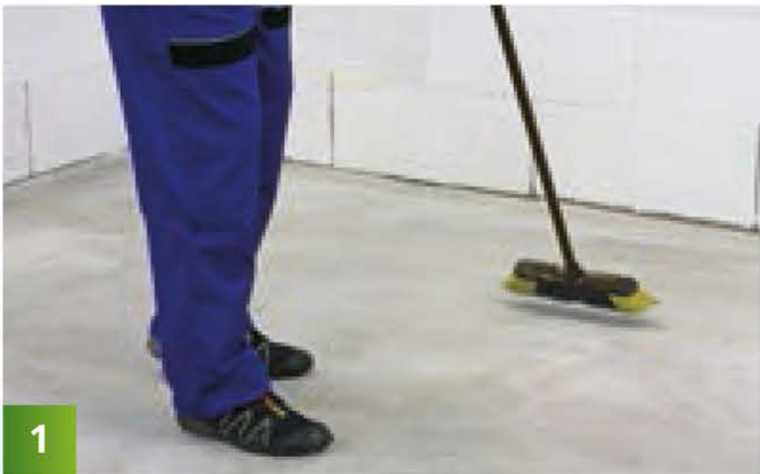
Únosný, čistý a pevný podklad očistíme od hrubých nečistôt, napríklad metlou.
