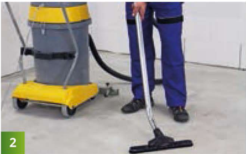
Na úplné dočistenie podkladu použijeme priemyselný vysávač.
