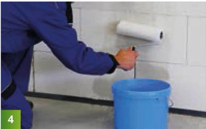
Steny napenetrujeme rovnakým spôsobom. Pred zahájením ďalších prác musia napenetrované povrchy dôkladne vyschnúť.
