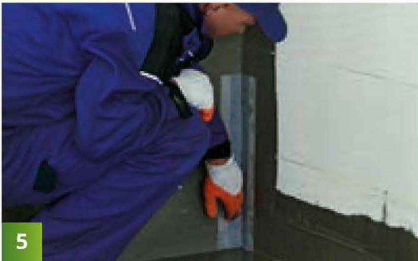
Na pripravený podklad (zatvrdnutá stierka, vyschnutá penetrácia) natiahneme prvú vrstvu hydroizolácie. Do rohových styčných škár vlepíme tesniaci pás.
