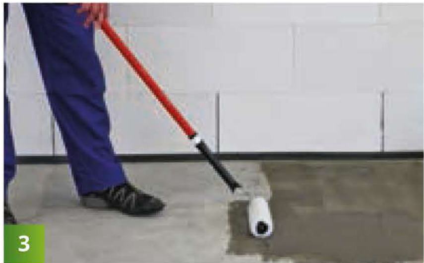
Podlahu napenetrujeme systémovou penetráciou. Aplikujeme valčekom alebo štetcom.
