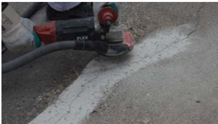
1. Povrch betónu sa prebrúsi v celej dĺžke trhliny brúskou s diamantovým kotúčom.
