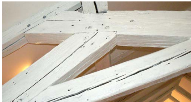
Realizácia protipožiarneho náteru FG500 FLAMGARD
