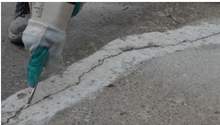
3. Trhlina sa preškriabe v celej dĺžke skobou.
