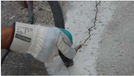
4. Opäť sa musí dôkladne odstrániť prach a úlomky po preškriabnutí trhliny.
