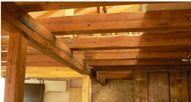
Realizácia protipožiarneho náteru FG700 FLAMGARD TRANSPARENT
