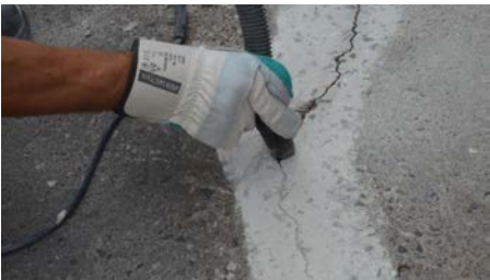
2. Musí sa dôkladne odstrániť všetok prach z trhliny a jej okolia.
