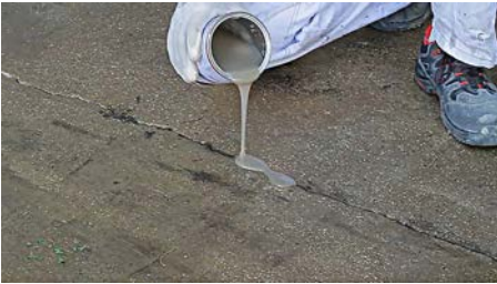
5. Trhlina sa zaleje rozmiešanou a natuženou zálievkovou hmotou HX110.
