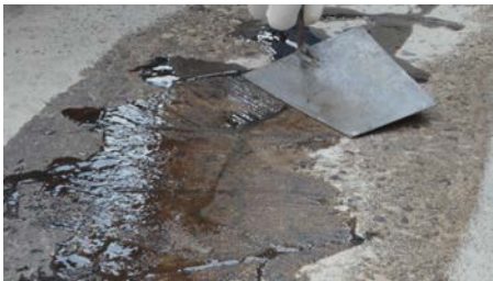
7. Na záver sa vykoná uhladenie, prípadne sa odstráni prebytok zálievkovej hmoty. Pred ošetrením náterom je vhodné plochu prebrúsiť.
