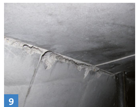
6 Štrkové hniezdo, odtok cementového mlieka
