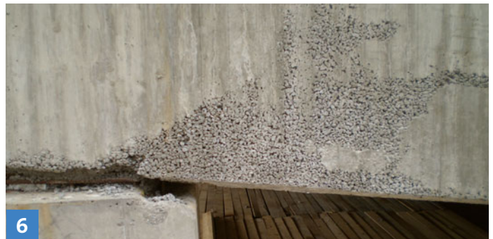
5 Odtok cementového mlieka
